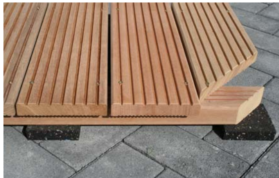
Bild 2: ISOPAT – punktuelle Unterlage
