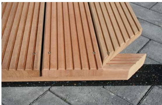
Bild 1: LOFTIS – durchlaufende Unterlage
